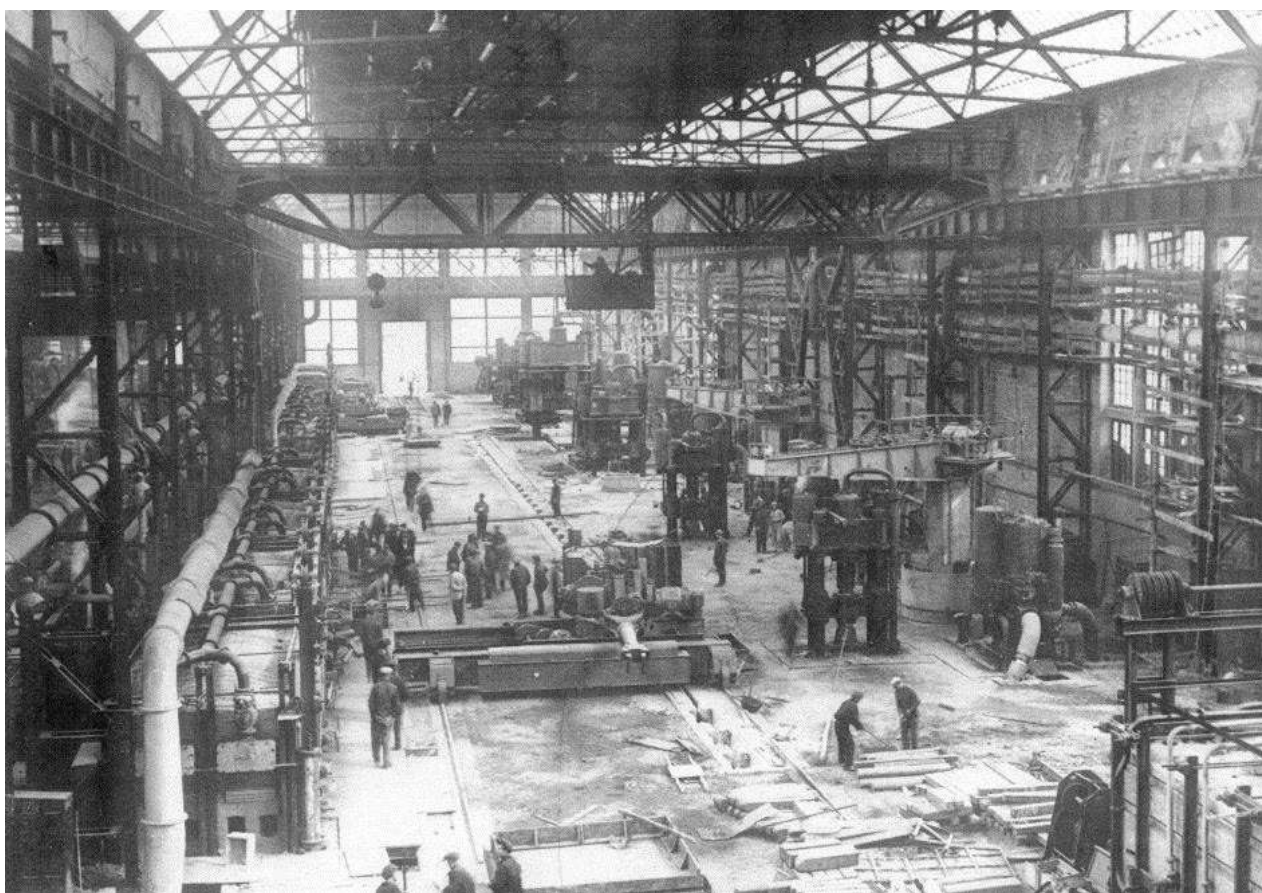
Монтаж оборудования прессового пролета кузнечнопрессового цеха Ворошиловградского паровозостроительного завода (1933 г.)
